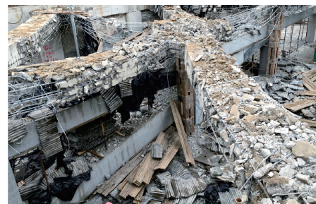
图11 爆破拆除效果
